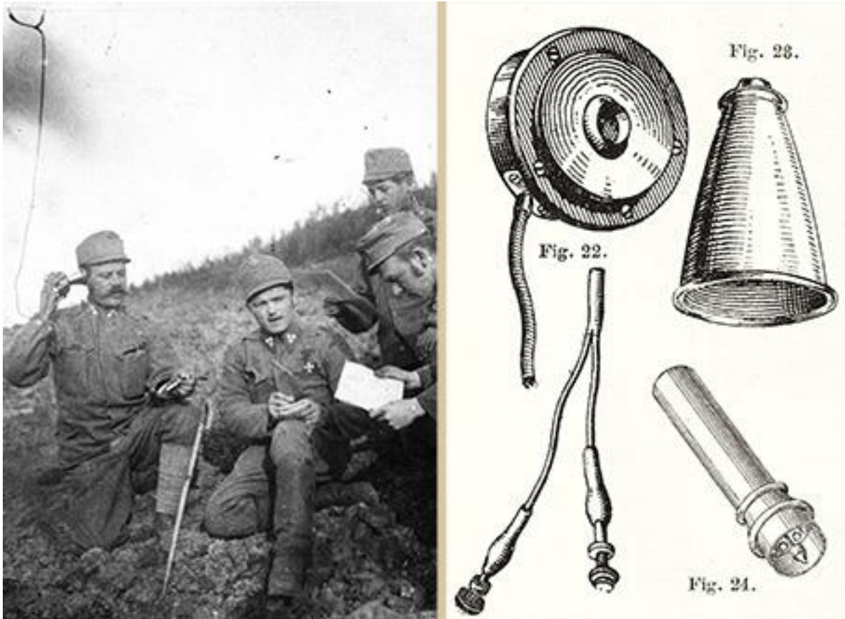
3. kép ▪ 7 M. dobozhallgató hangtölcsérrel és kézben a hívósíppal (Fortepan 39534, 1915.)
