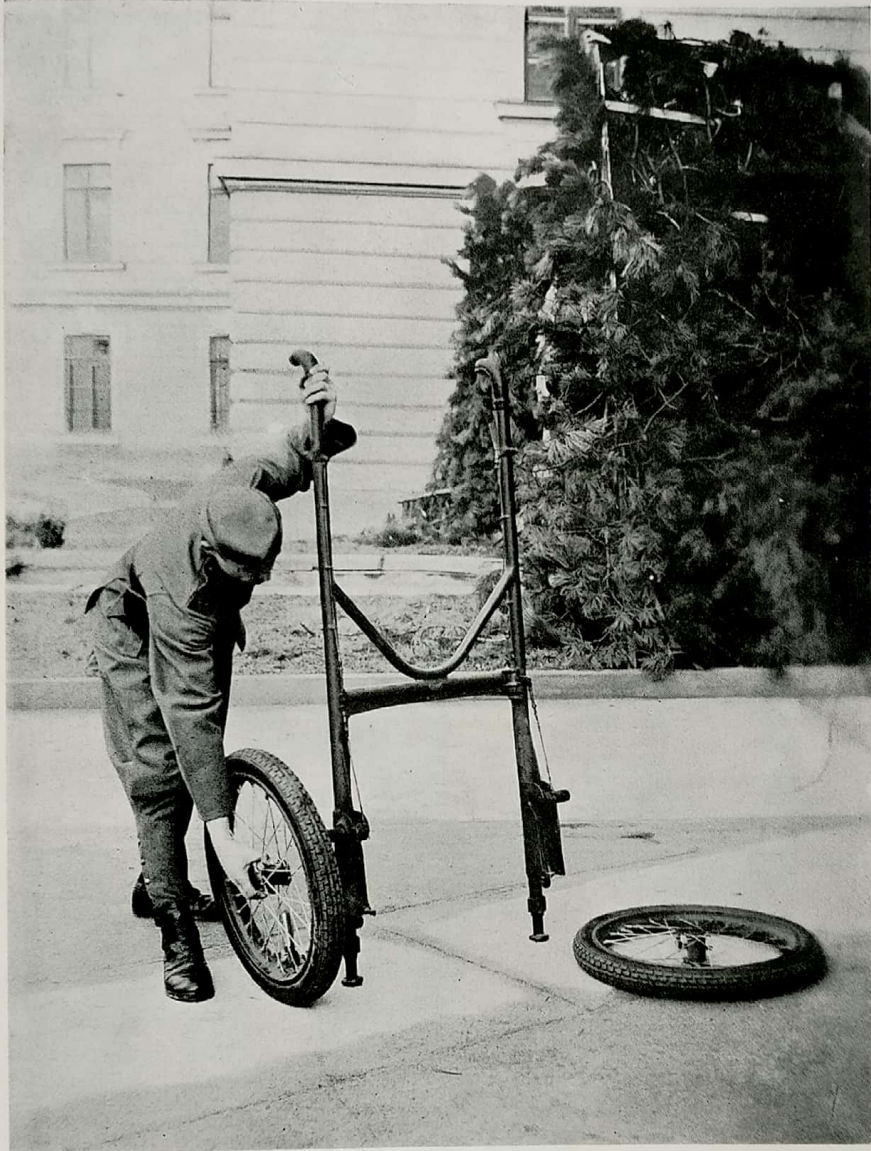
29. sz. ábra. A kábeltaliga összeállítása.
