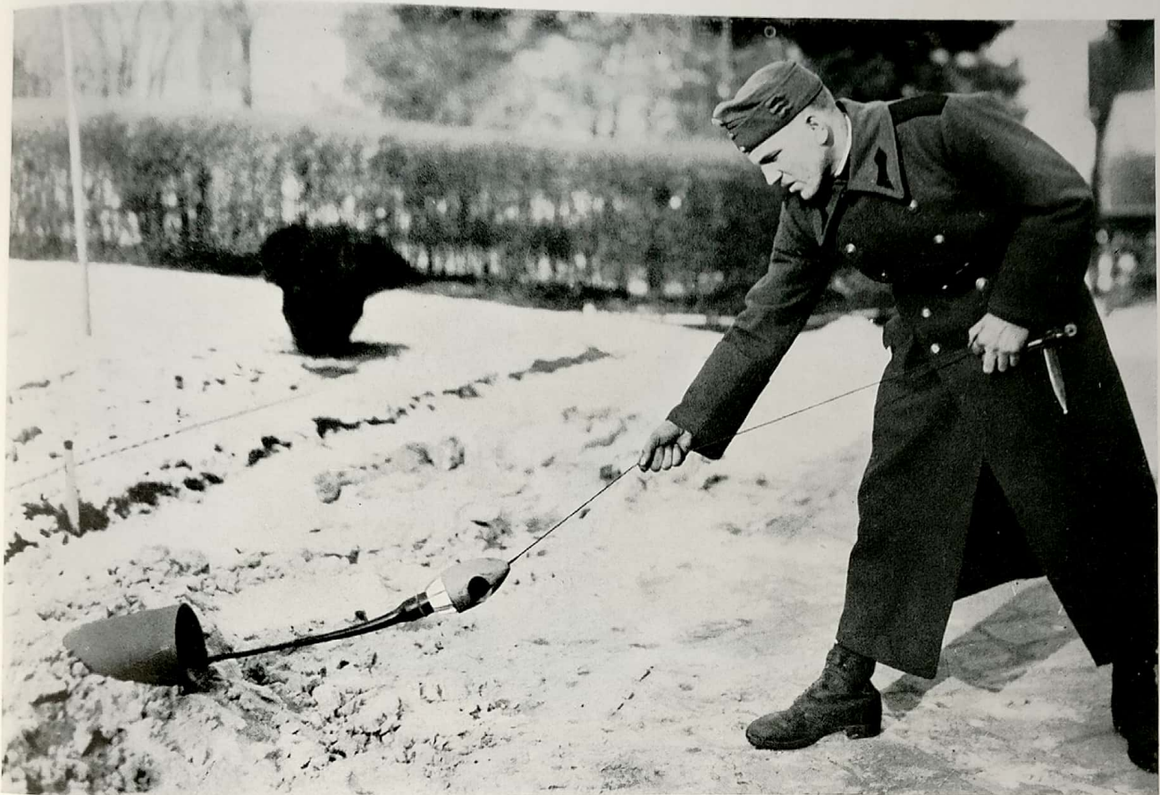
37. sz. ábra. Kábelfejjel való áthúzás.
