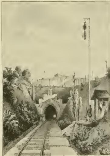
Abb. 24. Optische Signalisirung beim Eisenbahntunnel bei Pressburg [1850.]
