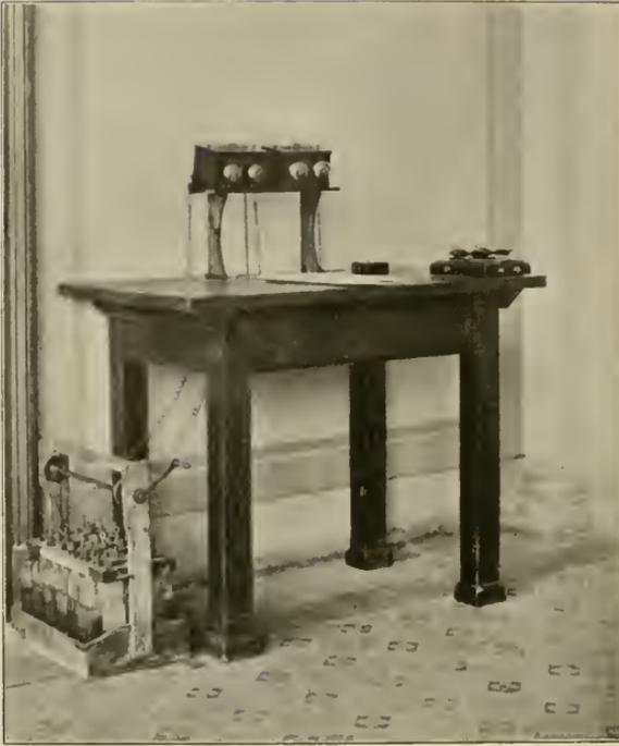
Abb. 58. Bain'sche Mittelstation mit Reserve-Indicator, Schefczik'schem Commutator und Smel-Batterie.
