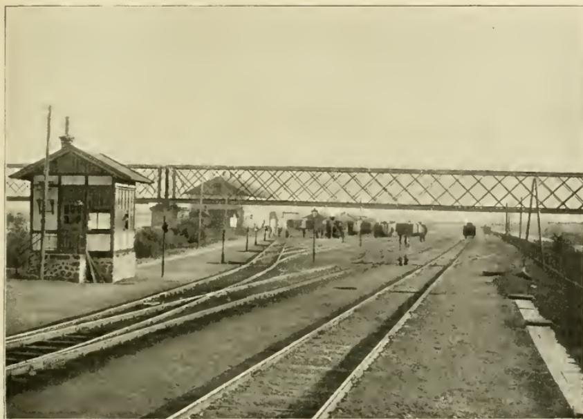
Abb. 15. Harfengeleiseanlage, Rangirbahnhof, Brigittenau. [Original-Aufnahme von H. Pabst.]
