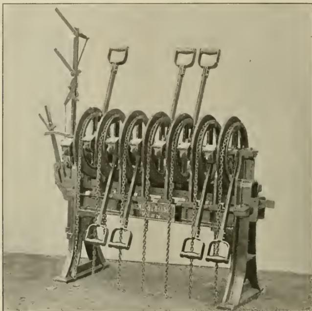
Abb. 45. Weichen- und Signal-Stellwerk von Siemens & Halske.
