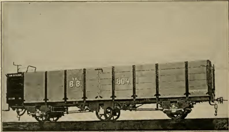
Abb. 179. Offener Güterwagen mit 10 t Tragfähigkeit.
